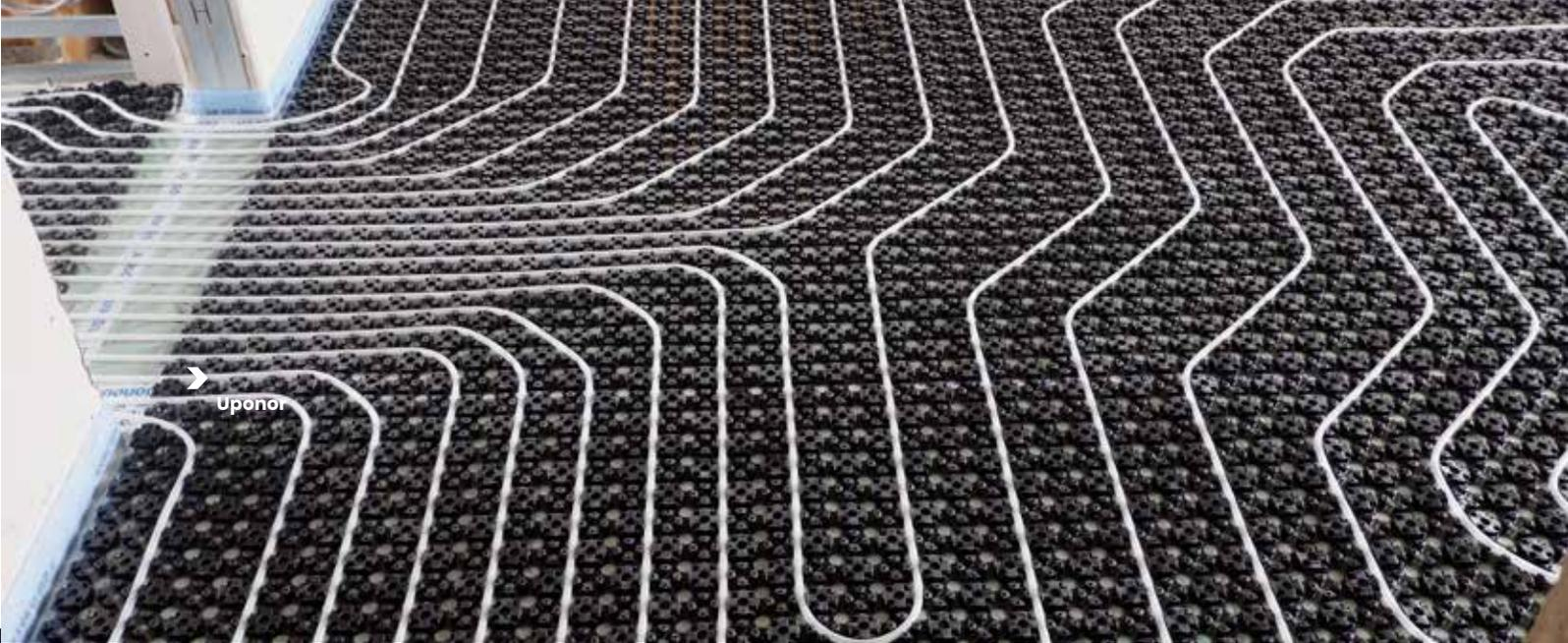
**>> Die Herausforderung bei Planung und Einbau der Fußbodenheizung lag vor allem in der geringen Aufbauhöhe des alten Plattenbaus von nur fünf Zentimetern. <<**
